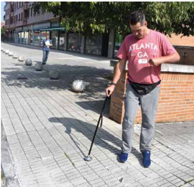
Usuarios del CAI de Viesques, participaron en un paseo donde se observaron incidencias en la accesibilidad en este caso baldosas rotas.
