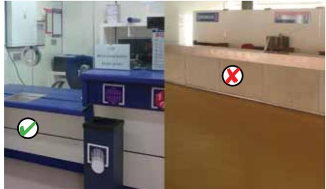
El mostrador que se muestra en la fotografía es un punto de atención accesible por lo que tal como viene definido por normativa debe constar de un plano de trabajo con una anchura mínima de 0,80 metros, estar situado a una altura máxima de 0,85 m y tener un espacio libre inferior de 70x80x50 cm (altura x anchura x profundidad) como mínimo.
