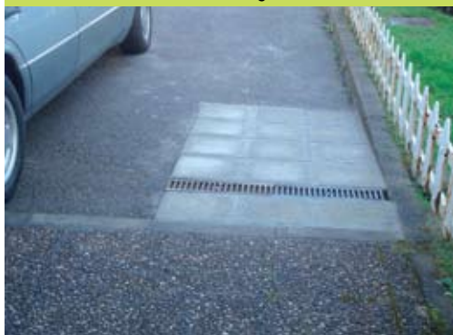
Acceso reformado del Colegio Clarín.
