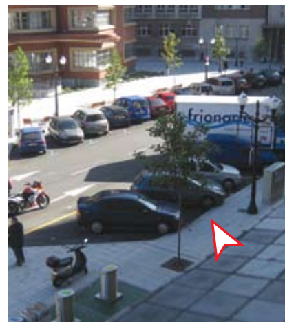
LAS PLAZAS DE APARCAMIENTO RESERVADAS , en las que no se respeta el número de plazas, lo que impide que los usuarios de silla de ruedas puedan acceder a su vehículo, al carecer de espacio de transferencia.
