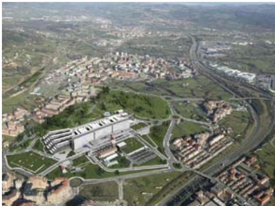
El nuevo Hospital Central de Asturias que en la actualidad se construye en la Caleyada (Oviedo).
