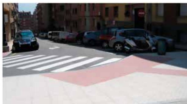
Vado peatonal correcto en remodelación de acera C/ Fernández de Oviedo esquina C/ Teodoro Cuesta.
