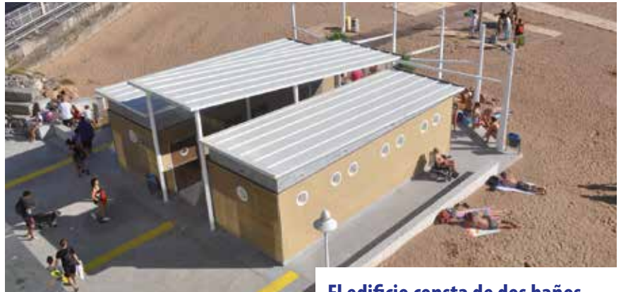
Edificio de Servicios de Playa Accesible.
